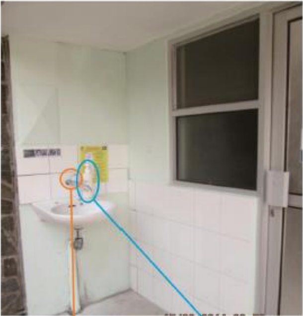
KRAN AIR PENCUCI
